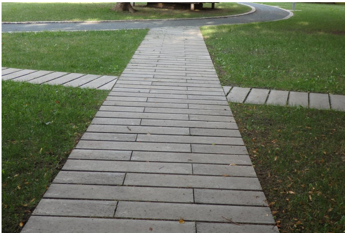
Pěšiny z betonových obrubníků, spáry do 10 mm, šíře pěšiny 1500 a 1000 m.
