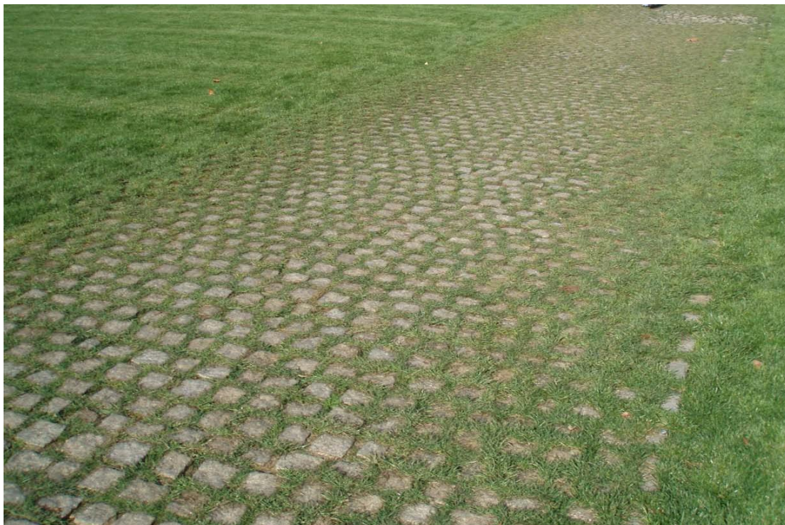
Pojízdná dlažba z žulové kostky, zatravněná spára.
